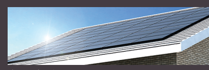
太陽光発電システム
