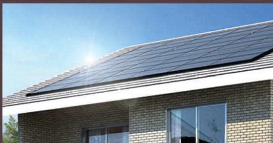
太陽光発電システム
