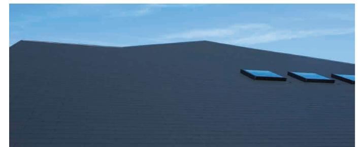
屋根材の表面には紫外線に強い無機コーティングを採用し、
