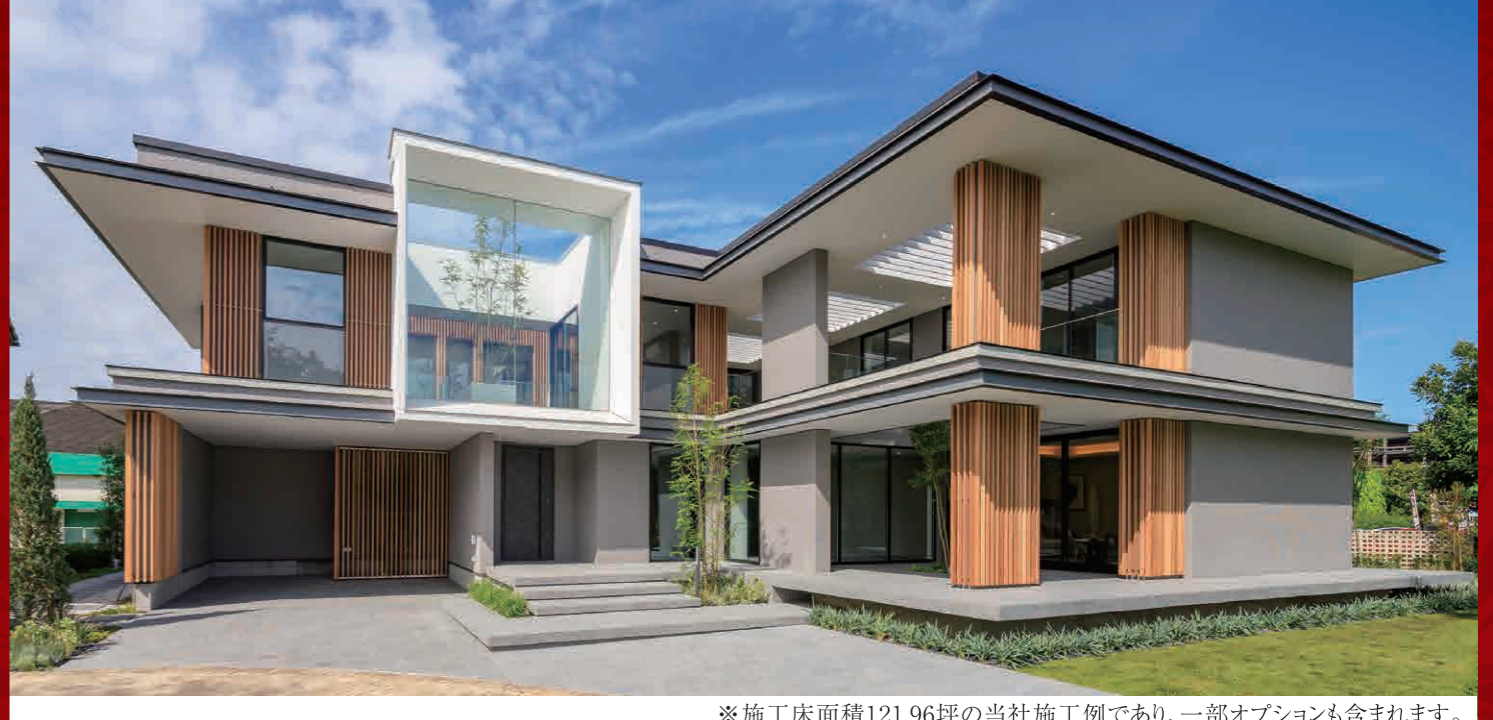
※施工床面積121.96坪の当社施工例であり、一部オプションも含まれます。
